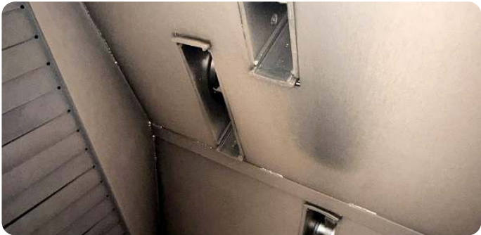
Parois doublées de plaques au manganèse.
